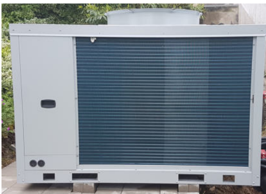
Die Außeneinheit der neuen Wärmepumpe vor der Philippuskirche. (Foto: H. Kilian)
