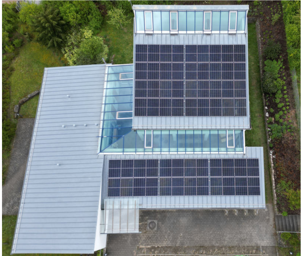
60 neue Solarpaneele mit einer Leistung von 24 kW liefern Strom für die Philippuskirche. Überschüsse werden ins öffentliche Netz eingespeist. (Foto: Heinrich Kilian)
